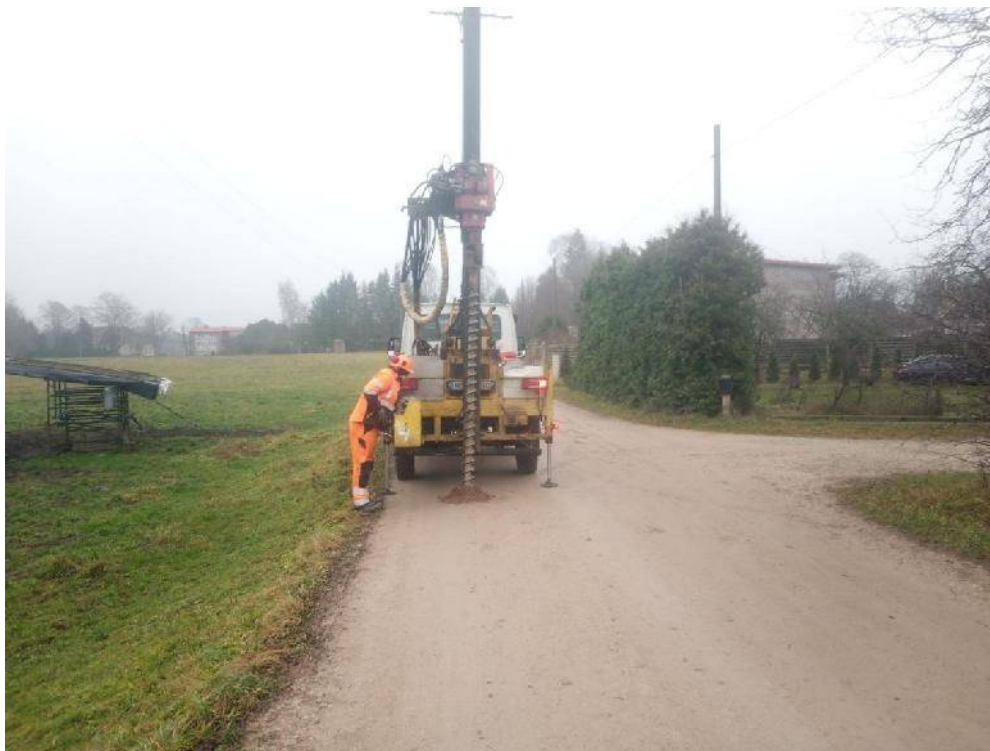
1 pav. Lauko darbai ties gręžiniu Nr.3
